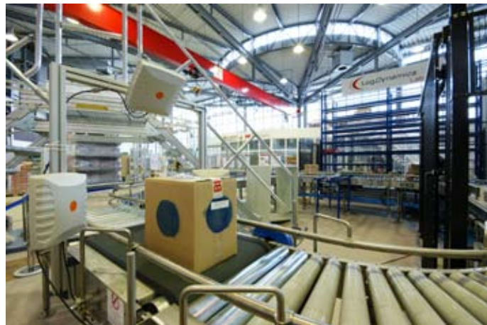
Neue Produkte und Anwendungen können im LogDynamics Lab in praxisnaher Umgebung erprobt werden.
